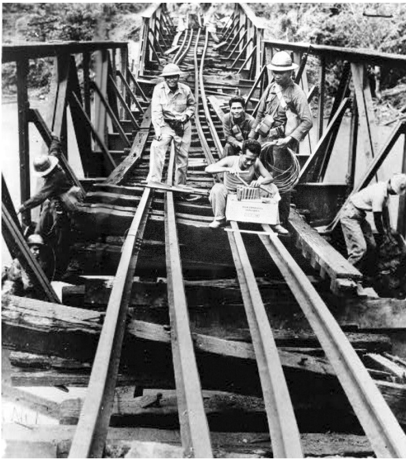
Soldados filipinos do 14º Regimento de Engenharia preparam uma ponte para demolição. O sucesso da retirada dependeria em grande parte dos engenheiros – eles deveriam manter estradas e pontes à frente das colunas em retirada e destruir as pontes e bloquear as estradas já ultrapassadas prejudicar o avanço japonês.
